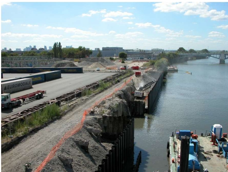
Construction du quai à la suite des démolitions préalables
